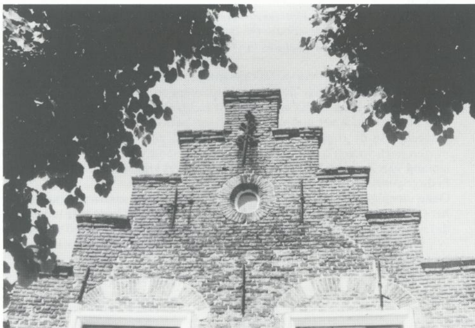
Monumentale gevel in de Voorstraat.
