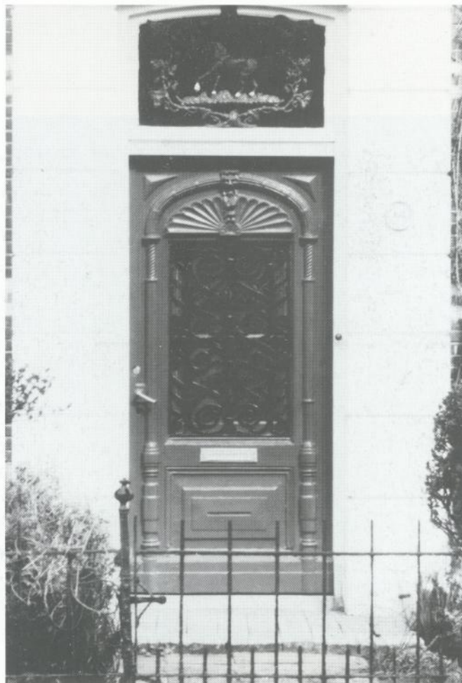
Markant entree van het pand hoek Lijnbaanweg/Pickéstraat.
